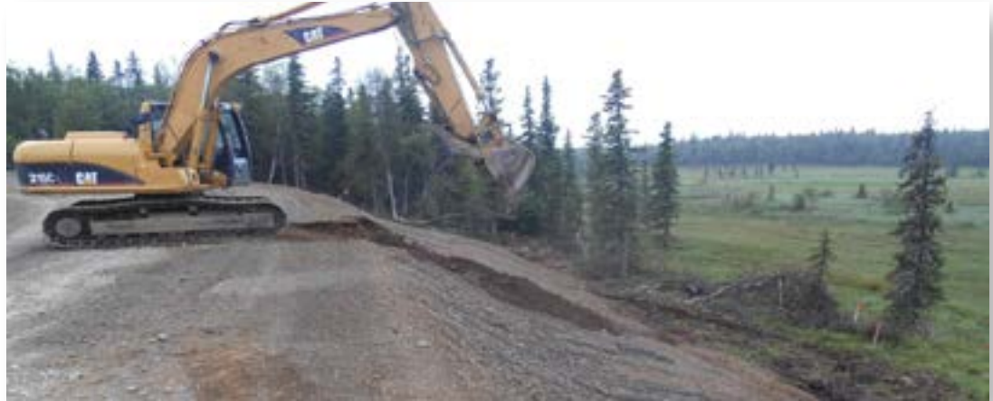
La importación de tierra vegetal se consideró demasiado costosa, por lo que se requirió vegetación en el material base disponible.
