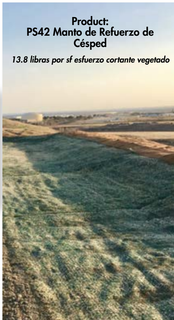
Vertedero 'Sunset Farms' antes de la germinación. Se pueden ver mantas de coco en el lado de la pendiente descendente de las bermas. Instalación verano y otoño de 2016.
